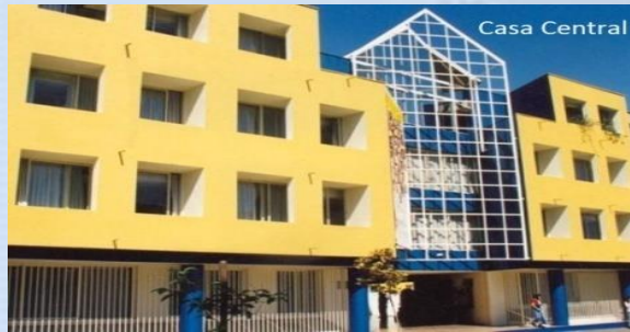
Casa Central Costado del Patio Central
